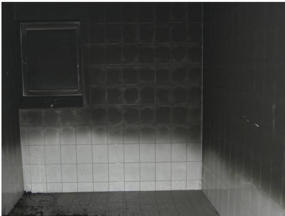
Bei diesem Bild ist zugleich zu beachten, dass sich die Rußschicht rechts neben dem liegenden Körper bis zum Podest hinzieht. Dies dürfte dem Brandverlauf mit der mutmaßlich in diesem Bereich entstandenen Öffnung der Matratze und dem dort liegenden Brandherd zuzuweisen sein. Gleichwohl vergeht bis zu der starken Rußablagerung an den Wänden einige Zeit, wie man dem Unterschied der Rußschicht auf den Zellenwänden und der nach etwa 5 Minuten geöffneten Zellentür entnehmen kann.
